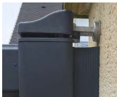
Joint d'occultation latéral pour portail et portillon
